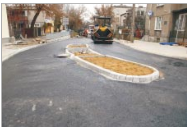
Rondo już prawie gotowe
