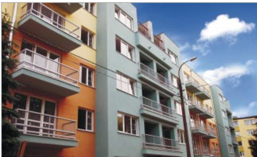
Nowy budynek komunalny przy ul. Szancera 5
