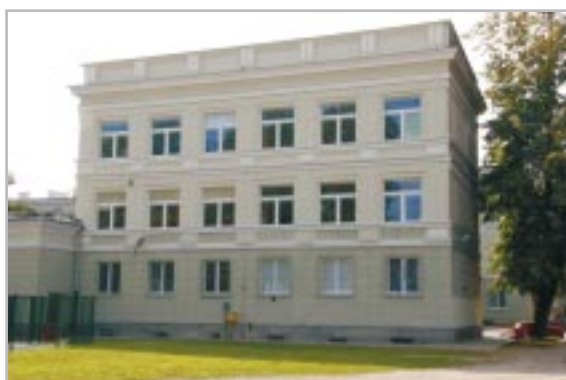
Nowa elewacja budynku Szkoły Podstawowej Nr 14
