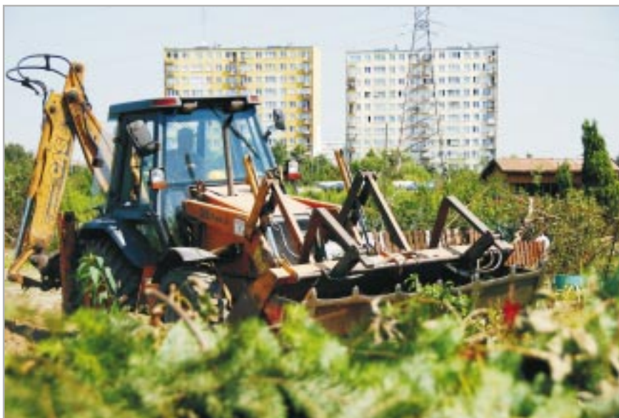
Przygotowanie terenu pod budowę trasy S2
