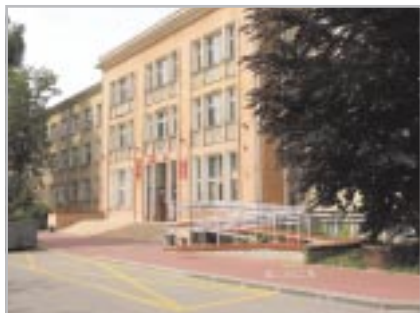
Budynek Zespołu Szkół nr 42
