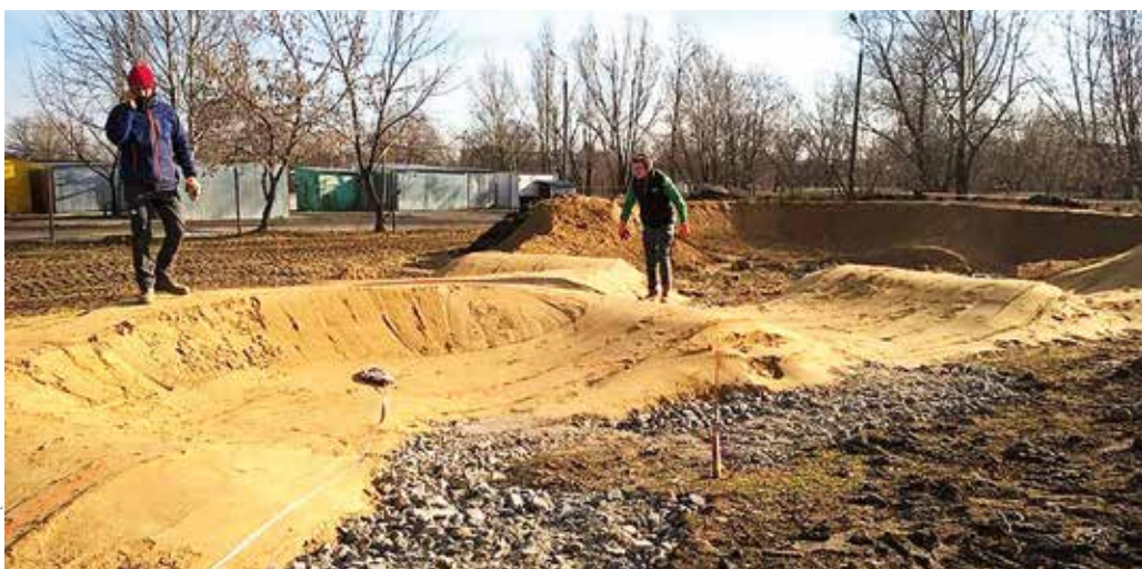
Budowa toru rowerowego przy ul. Gierdziejewskiego, 20 lutego 2018 rok.
